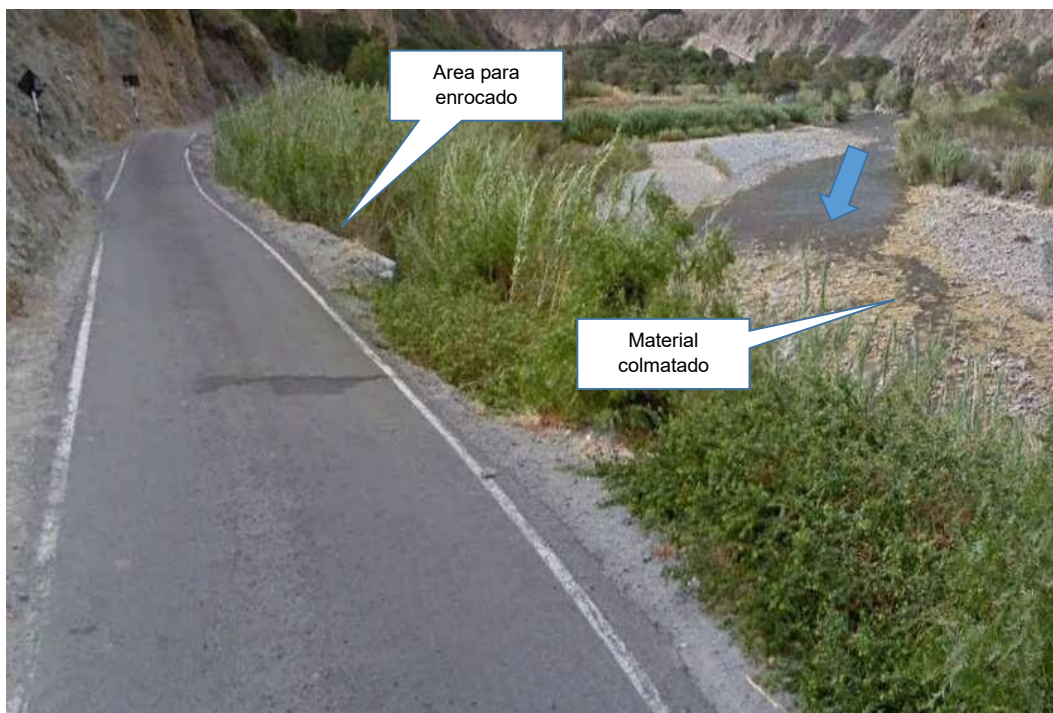
FIGURA N°02: TRAMO CRÍTICO, ZONA PARA ENROCADO
